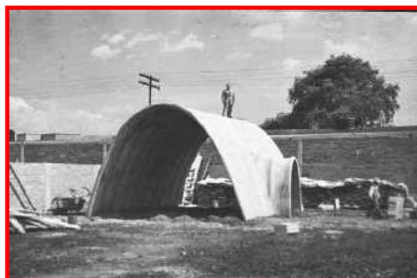
Il primo guscio (cascarones<sup>14</sup>) che ha costruito Candela, è stata una volta funicolare sperimentale, nell'estate del 1949. Per la sua costruzione seguì l'esempio di alcuni prototipi eretti in Inghilterra durante la Seconda Guerra Mondiale. Sembra che l'inventore della
