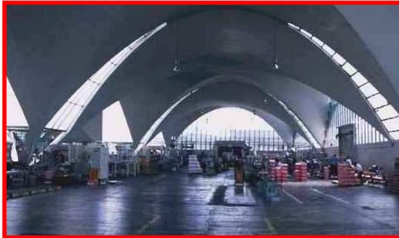
Per l'edificio della Bacardi, Candela si ispirò alla forma dell'aeroporto di San Luis Missouri di Minoru Yamasaki. Sei grandi cupole di 30 metri di luce e 4 cm di spessore, disposte a
